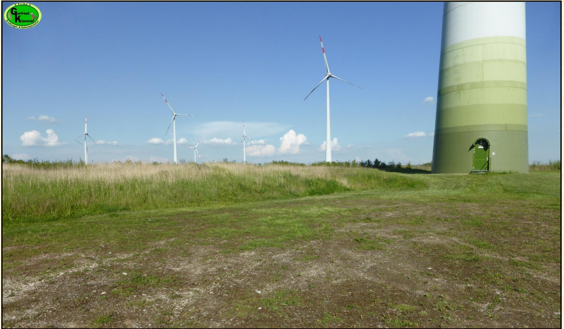
Blick in den Windpark Brüssow-Wolfsmoor
