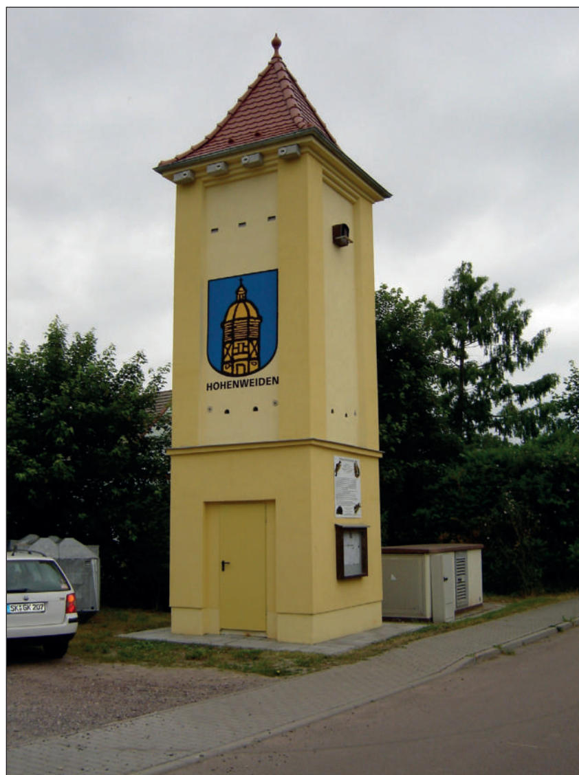
Abbildung 1: Trafohaus in Hohenweiden, OT Rockendorf mit Infotafel und verschiedenen Brutmöglichkeiten (Foto: GERFRIED KLAMMER)
