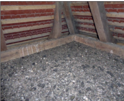
Abbildung 5: Dachstuhl im ASH Mösthinsdorf (Foto: GERFRIED KLAMMER)
